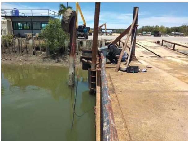
ข. การติดตั้งเครื่องวัดระดับน้ำบริเวณท่าเทียบเรือ บริษัท ซี พอร์ท จำกัด
