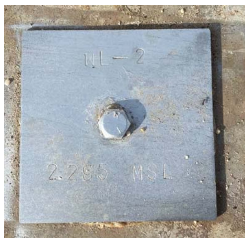
ค. หมุดควบคุมบริเวณท่าเทียบเรือ บริษัท ซี พอร์ต จำกัด
