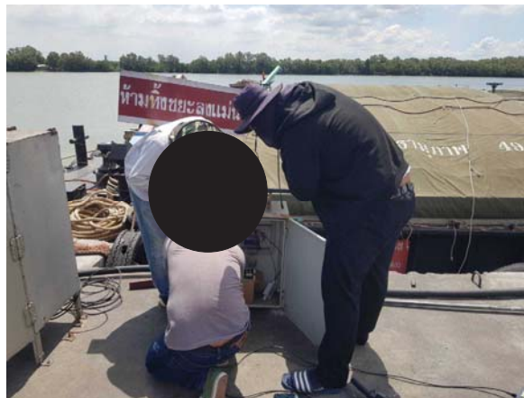
ก. การติดตั้งเครื่องวัดระดับน้ำบริเวณท่าเทียบเรือ บริษัท เอเชีย โกลเด็นท์ ไรซ์ จำกัด
